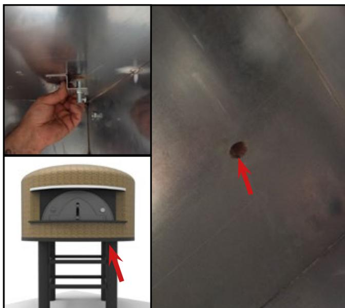
**4** - Fissare la staffa per il blocco sonda in corrispondenza del foro presente sotto il forno sul lato destro
