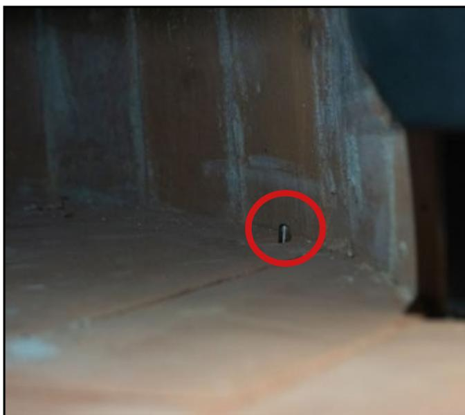
**5** - Inserire la sonda nel foro in modo che sporga 1cm sul piano refrattario
